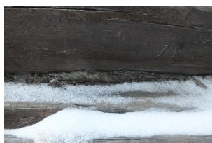
Eine Fuge, die mit Hanf-Dichtungsband verschlossen wurde, kann materialbedingte Breitenänderungen der Fuge leicht mitmachen, ohne undicht zu werden, weil die Hanffaser-Materialien sehr elastisch sind.
